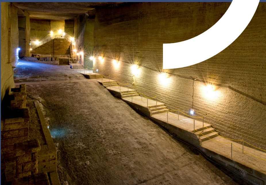
「大谷石地下採掘場跡(大谷資料館)」(栃木県宇都宮市) / 鹿沼相互信用金庫
